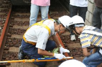
↑線路の幅、異常なし!
